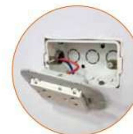
Colocar tornillo antes de colocar el soporte
